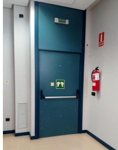
S4: Puerta salida de planta a escalera E2.
